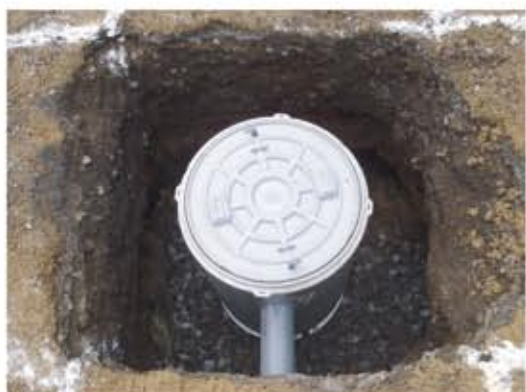
⑤処理槽据付・配管接続
