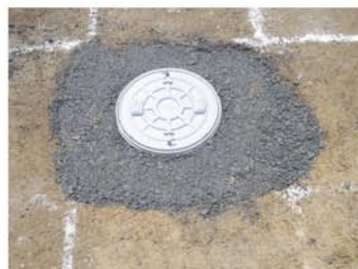
⑧上部埋戻して完成
