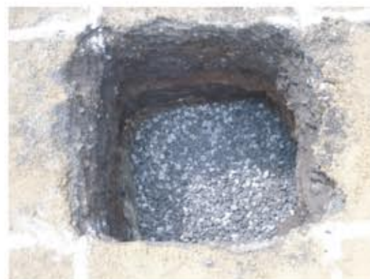
④処理装置下部まで 20-30 碎石充填
