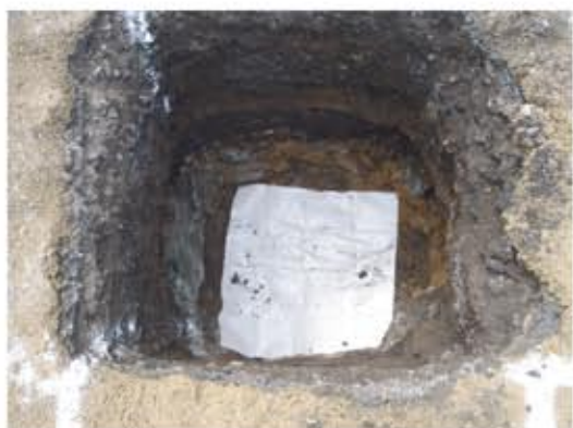
③止水シート敷設
