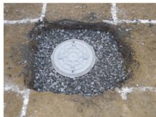
⑥処理槽天端まで 20-40 碎石充填
