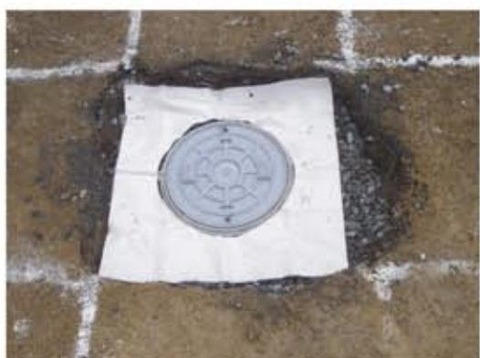
⑦土砂流入防止シート敷設
